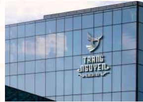
Chữ nổi Inox được cắt bằng công nghệ CNC gắn trên mặt kính ngoài trời của tòa nhà
